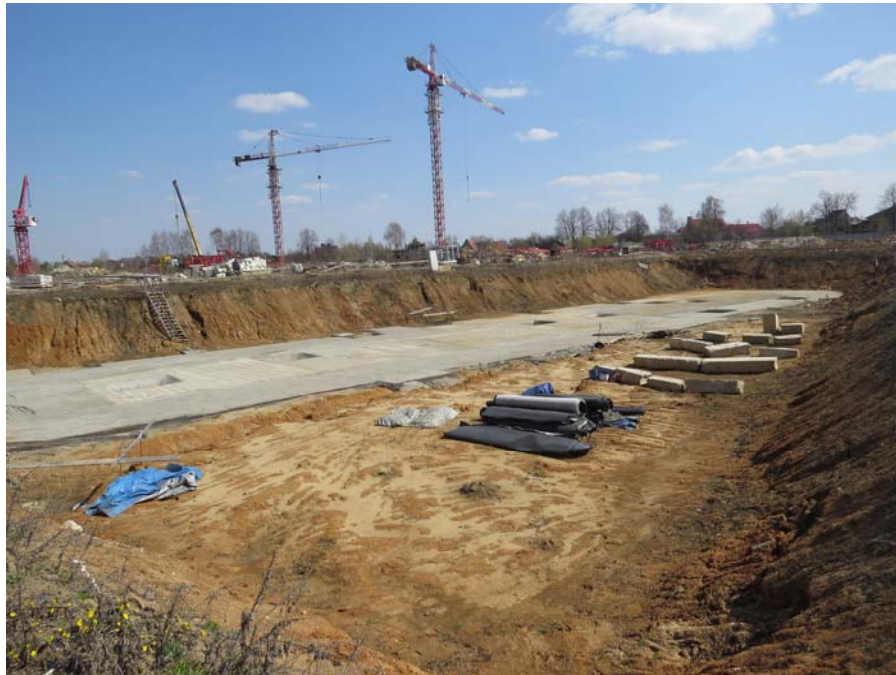
Рис. 1.1. Общий вид котлована жилого дома №12 (корпус 12.1)
