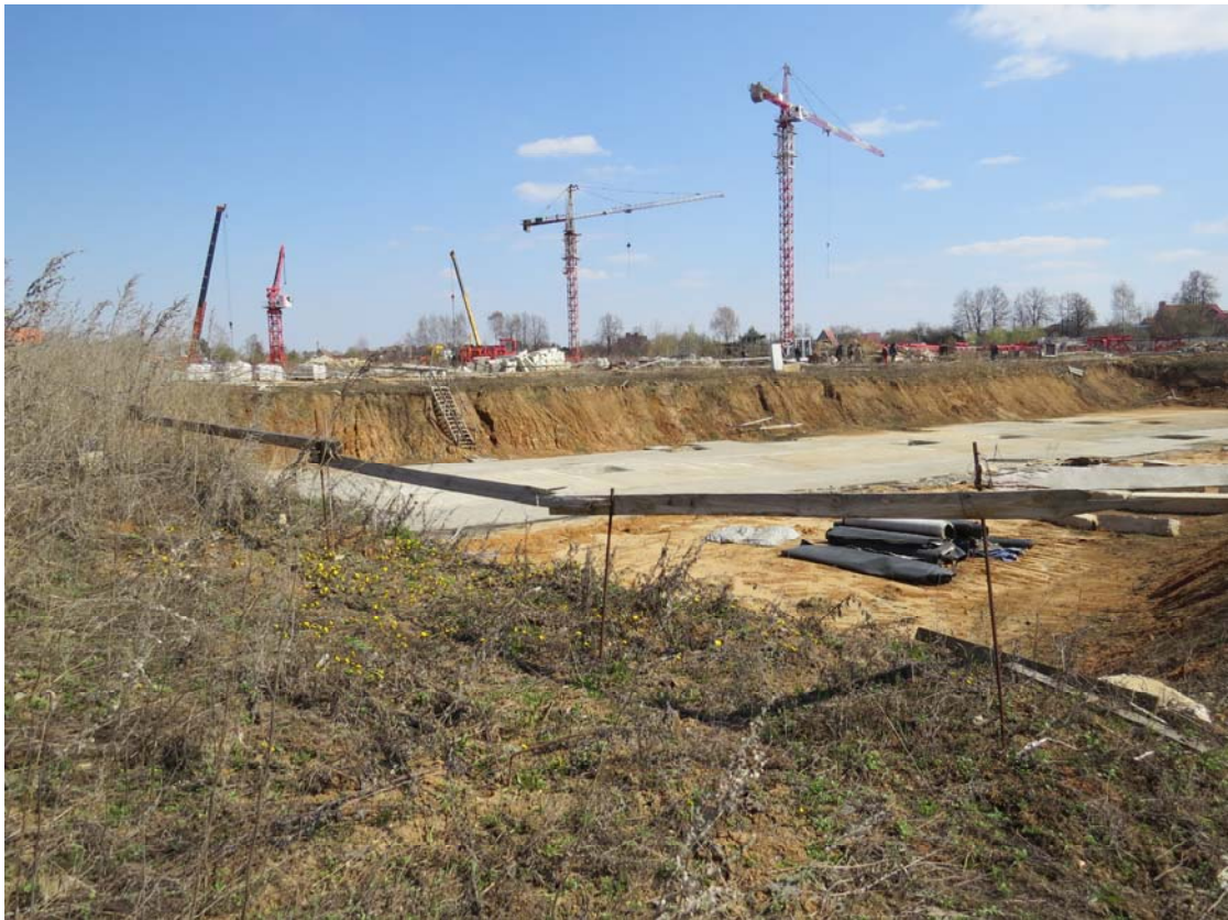
Рис. 3.3. Общий вид ограждения котлована корпуса №12.1
