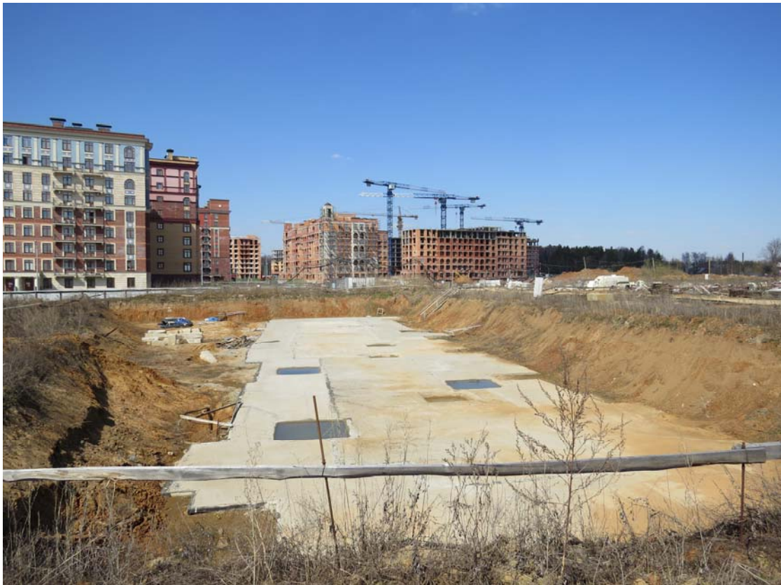
Рис. 3.1. Общий вид котлована корпуса №12.1
