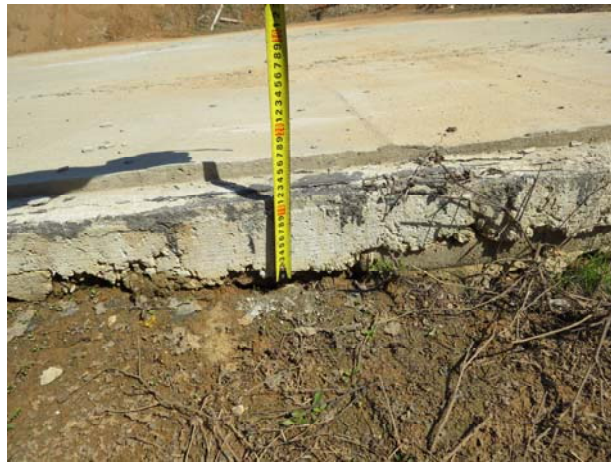
Рис.2.1. Замер толщины подбетонки под фундаментную плиту жилого дома корпус № 12.1
