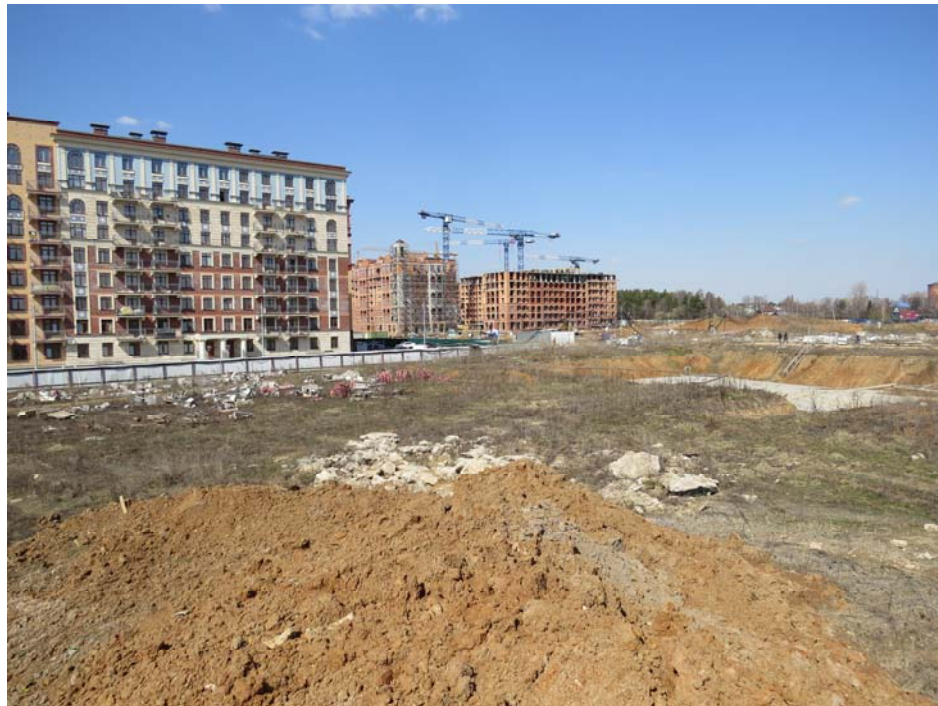
Рис. 1.2. Общий вид котлована жилого дома №12 (корпус 12.2 и корпус 12.1)
