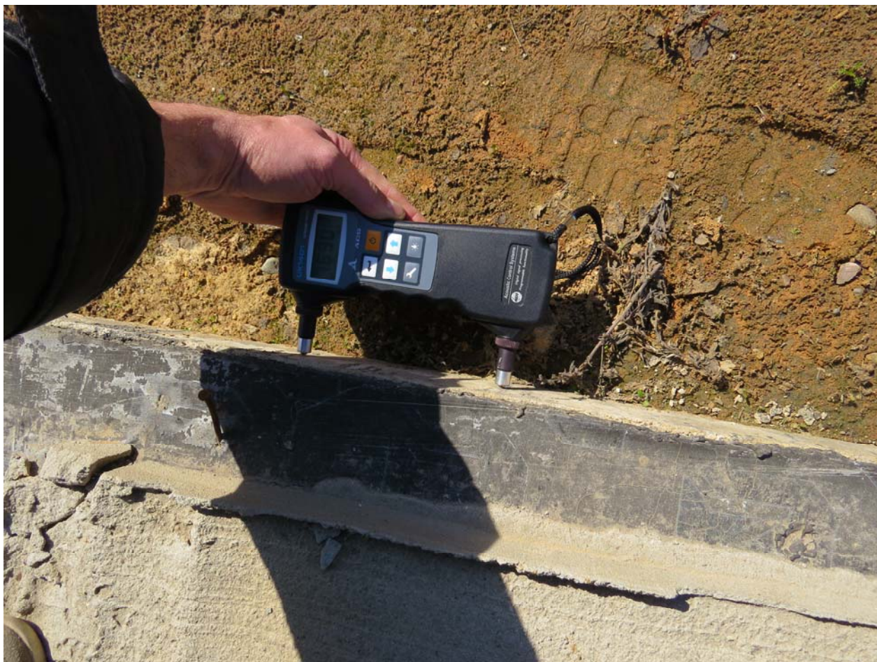
Рис. 4.3.1. Определение прочности бетона подбетонки в котловане корпуса 12.1 ультразвуковым методом прибором «UK1401»
