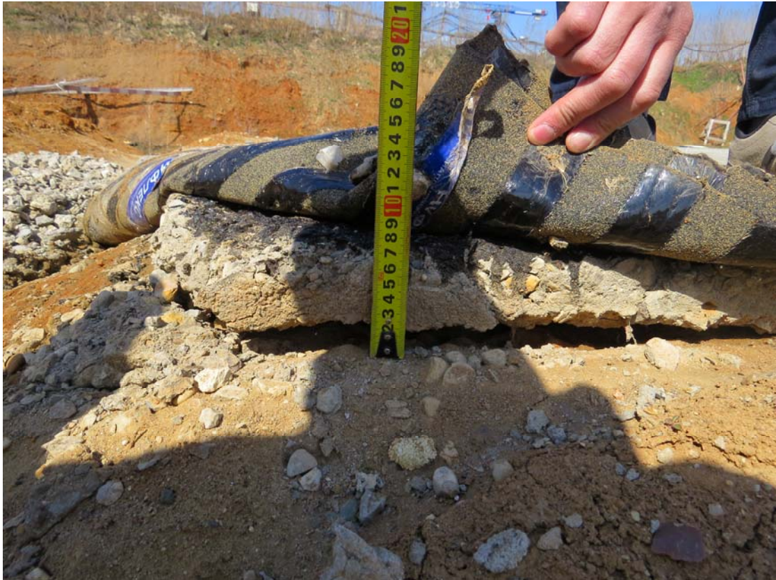
Рис. 3.7. Замер толщины подбетонки в котловане корпуса №12.1
