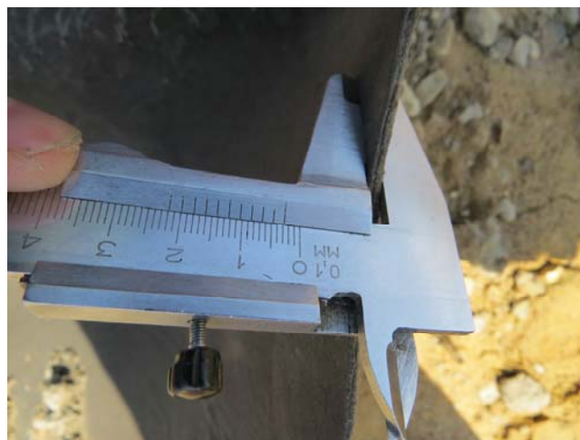
Рис.2.2. Замер толщины горизонтальной гидроизоляции под фундаментную плиту жилого дома корпус № 12.1
