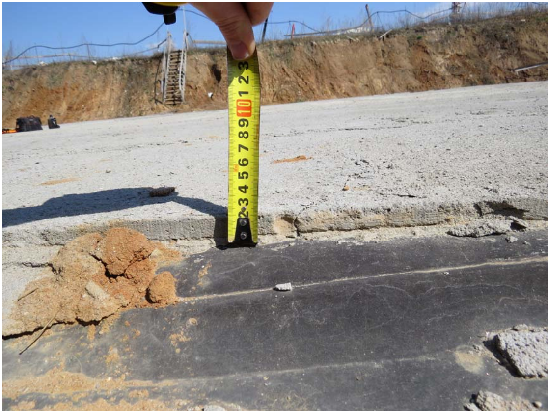
Рис. 3.8. Замер толщины цементно-песчаной стяжки для защиты горизонтальной гидроизоляции фундаментов корпуса 12.1
