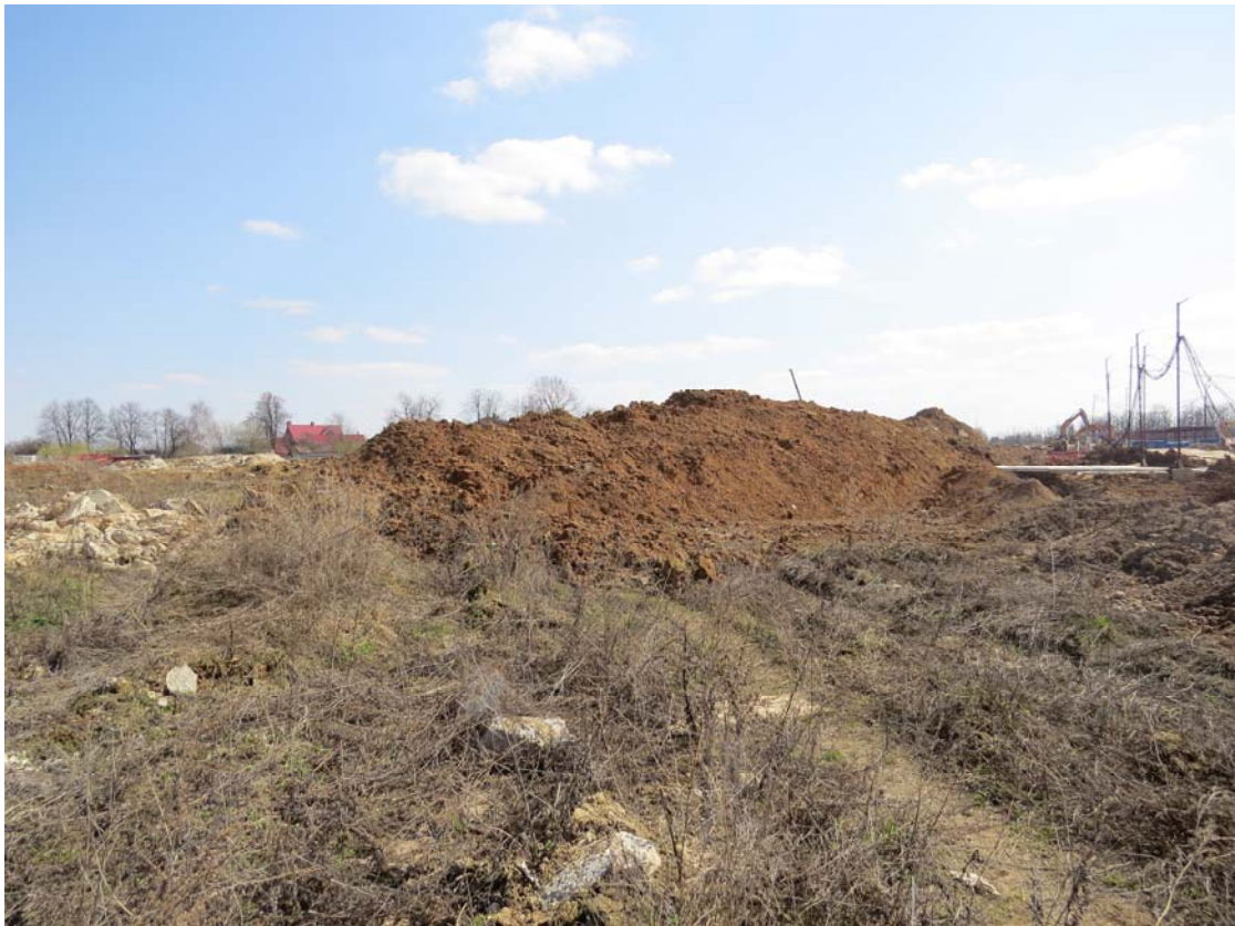
Рис. 3.4. Общий вид грунтовой насыпи при разработке котлована корпуса 12.2
