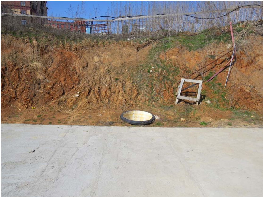
Рис. 3.6. Общий вид зумпфа для откачки воды с котлована корпуса 12.1
