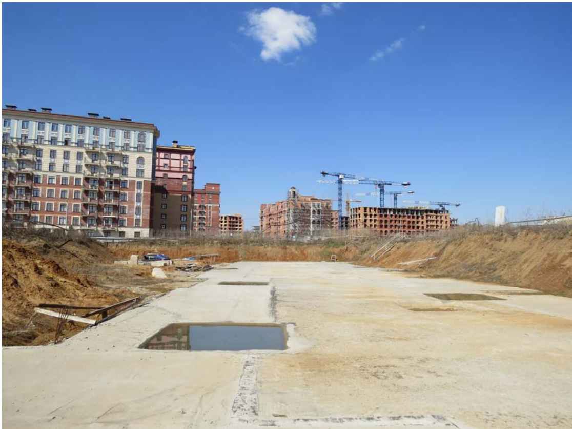
Рис. 3.5. Общий вид подбетонки в котловане корпуса №12.1
